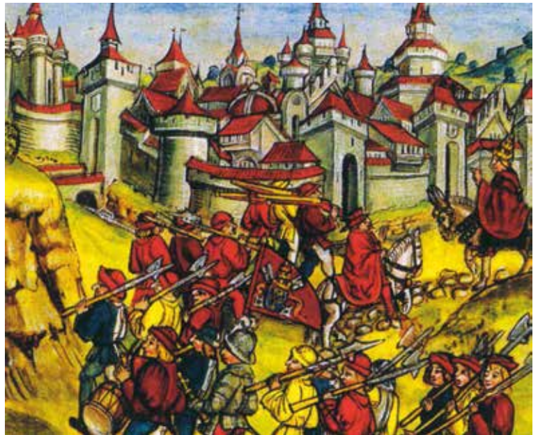
Eintreffen der Schweizer in Rom, Papst Julius II. empfängt die ersten Gardisten vor der Stadt.
